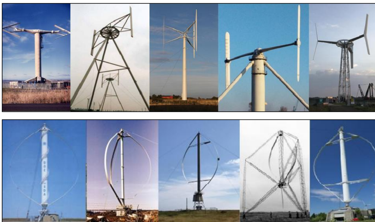
Фигура 18. Ветрогенератори с вертикална ос по модела на Дариус (Ф-конфигурация) и H-тип. (Източник: Möllerström, Erik et al. 2019)
